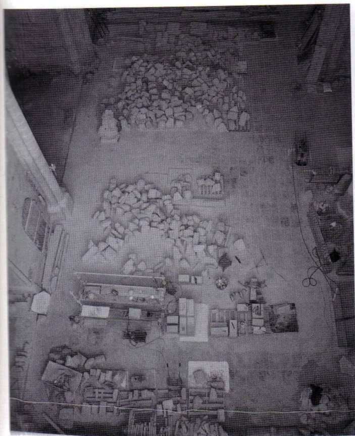
Interior de la iglesia durante las obras
